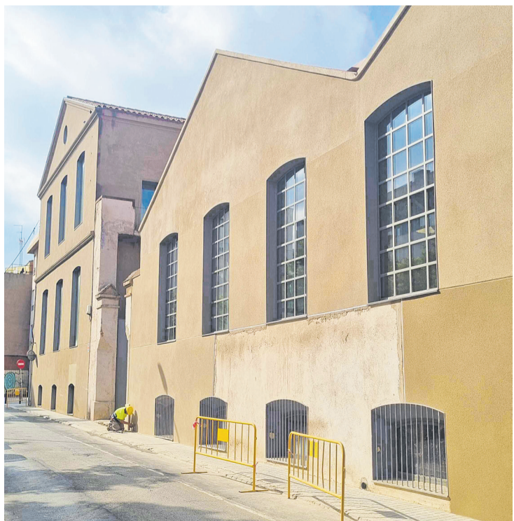
Les obres de rehabilitació de la nau est del Vapor Pissit ja estan a la recta final, amb un any de retard respecte a la previsió / D.S.
