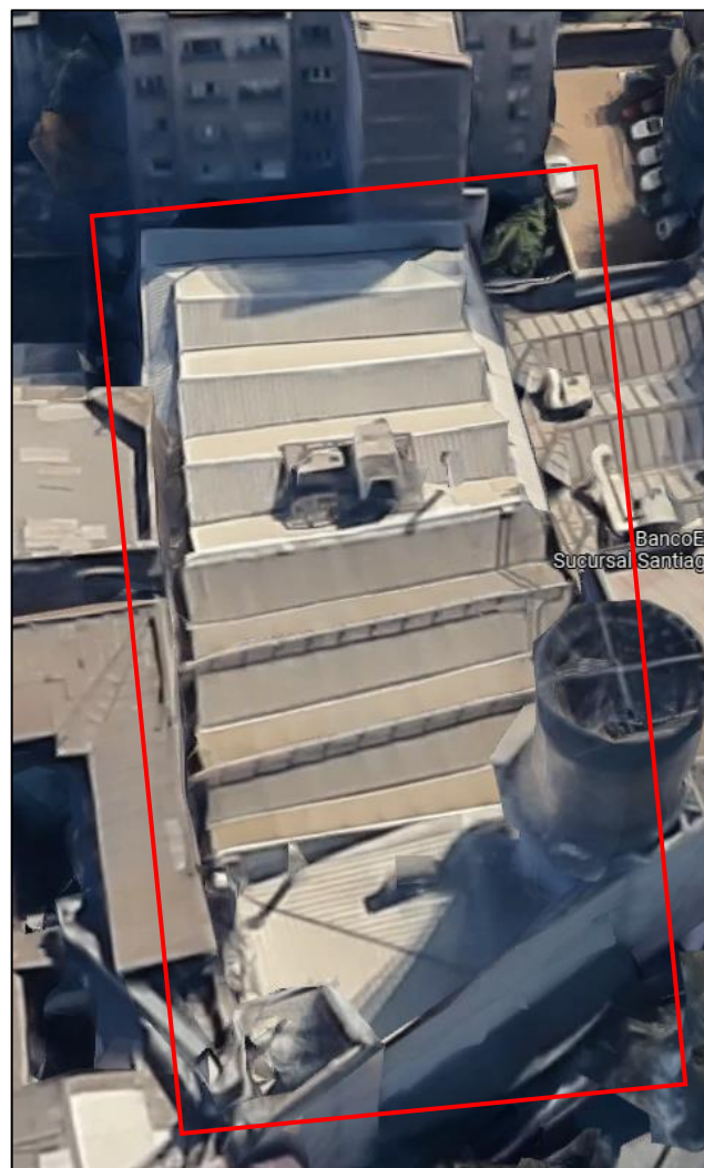
Figura 2: Imagen satelital. En recuadro rojo las instalaciones del Centro Arte Alameda (Fuente: Google Maps)
