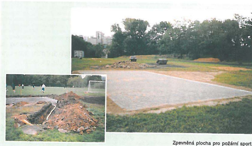
Zpevněná plocha pro požární sport.
