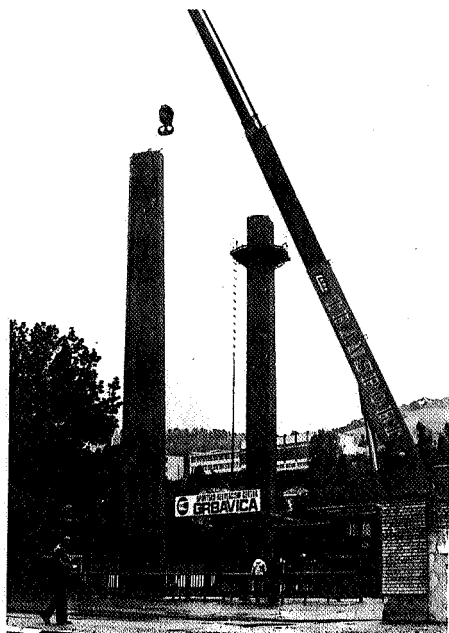
Montaža stuba reflektora na stadionu Grbavica
