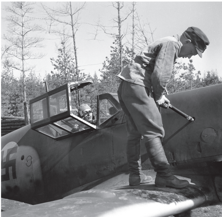
▼ Démarrage à la manivelle du Daimler-Benz DB 605 du Messerschmitt Bf 109 G-2 du lieutenant Jorma Saarinen (23 victoires), de la HLLv 24, à Suulajärvi le 12 mai 1944. La présence ou non du bosselage de capot permet de distinguer d'un coup d'œil les deux versions du célèbre chasseur livrés par le Reich à la Finlande.
