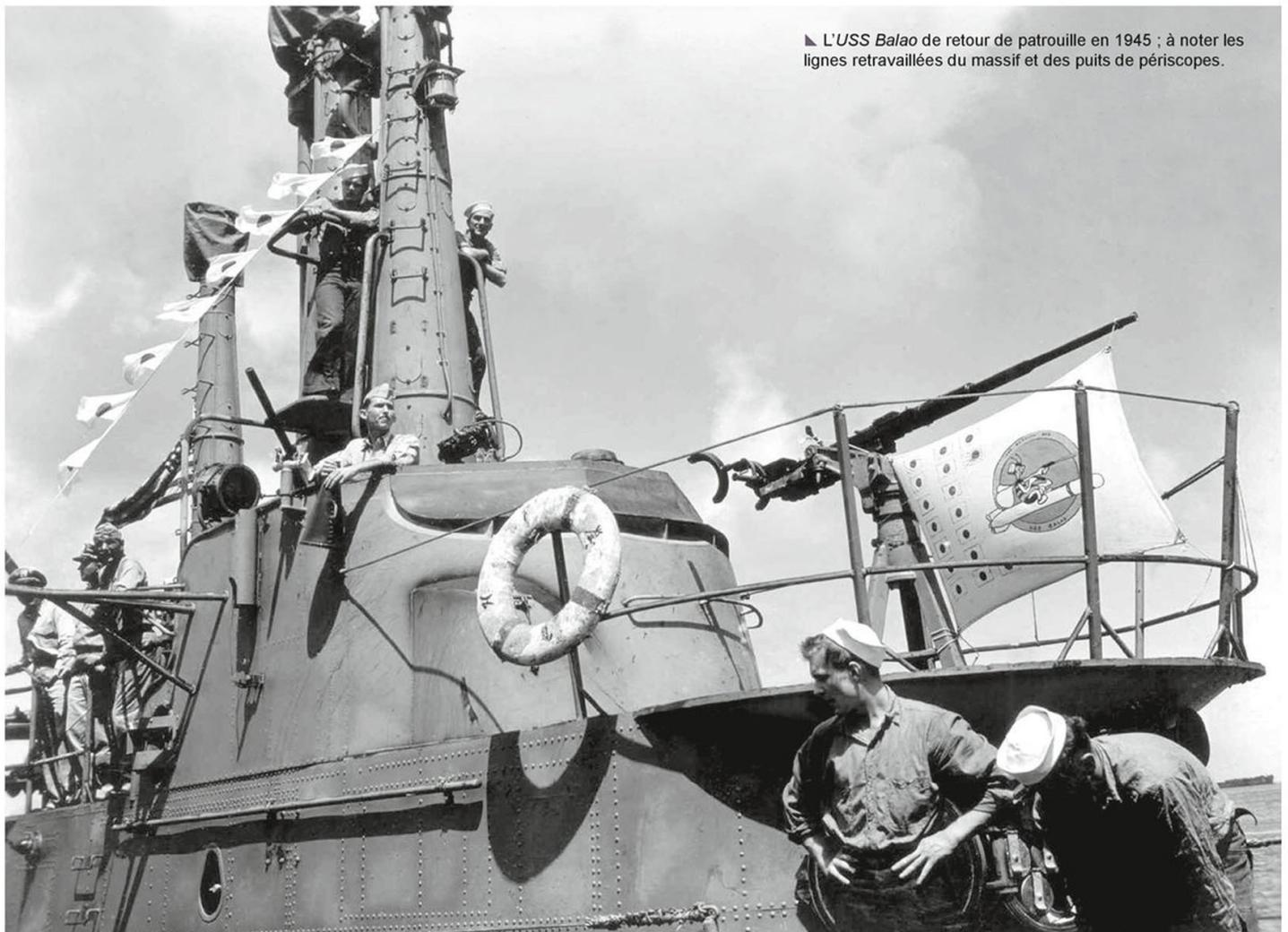
▲ L'*USS Balao* de retour de patrouille en 1945 ; à noter les lignes retravaillées du massif et des puits de périscopes.
