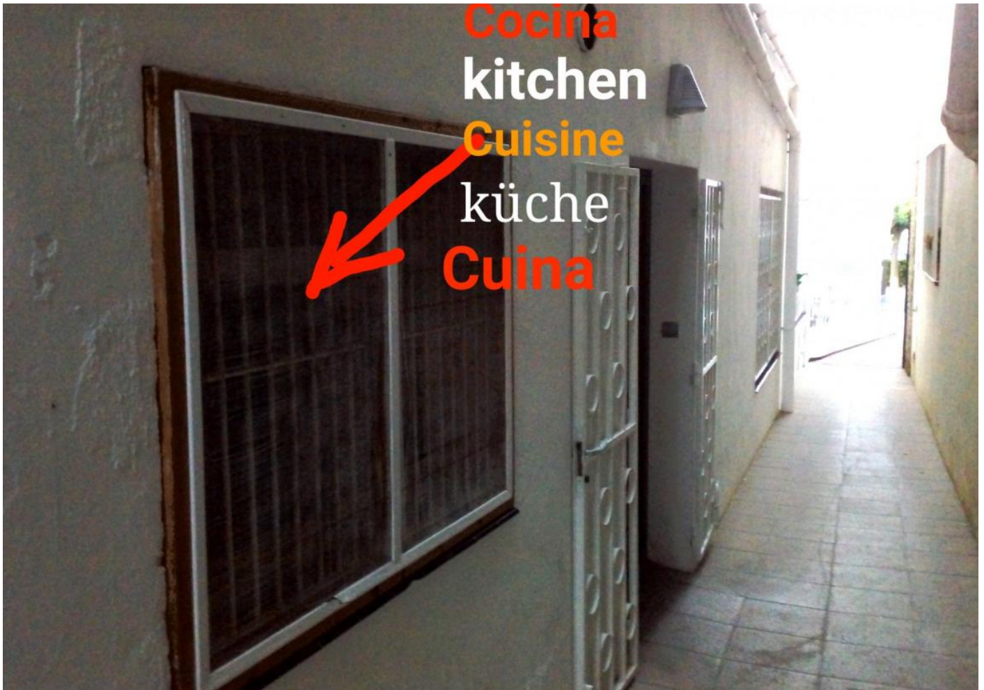
Photo de Fenêtre de la cuisine du restaurant du Hostal Santa Clara Estartit.
