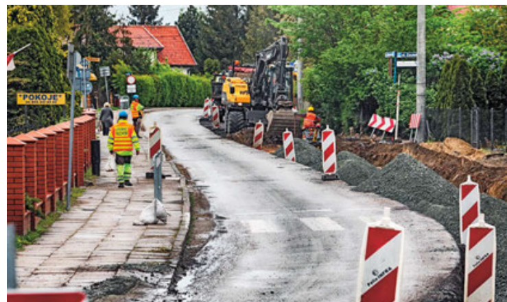
Rozkopana droga w Sztutowie.
