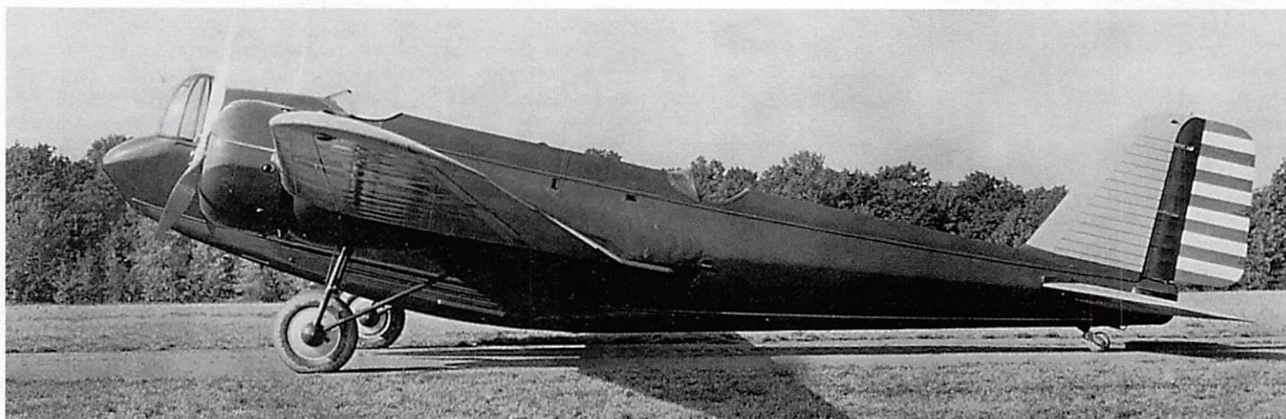
Le XB-907, prototype du Martin 123, dans sa deuxième version (XB-907A), c'est à dire avec la tourelle de nez, l'aile agrandie, des moteurs «Cyclone» plus puissants, de nouveaux capots, et le train d'atterrissage amélioré.
