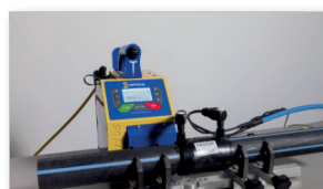
Commencer la soudure. Effectuer les contrôles nécessaires (alignement, profondeur d'insertion et indicateurs de fusion).
