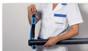
Coupez le tuyau avec le coupe-tube.
