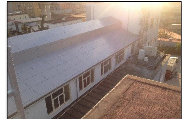
*State of the building after the work. Interventions: shaving and painting of facades, roof Alucobond, lining curtain wall of stairwells, photovoltaic system / Stato dell'edificio dopo il lavoro. Interventi effettuati: rasatura e pittura delle facciate, tetto in Alucobond, rivestimento in facciata continua del corpo scale, impianto fotovoltaico*
