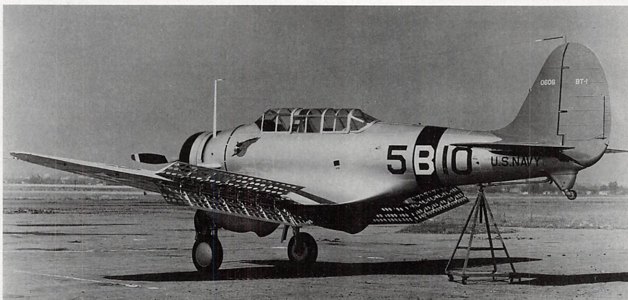
Ci-contre, le 10 mai 1938, le BT-1 n° 0606 de la VB-5, fait la démonstration des freins de piqué, percés de plus de 300 trous sur la recommandation des aérodynamiciens du NACA.
