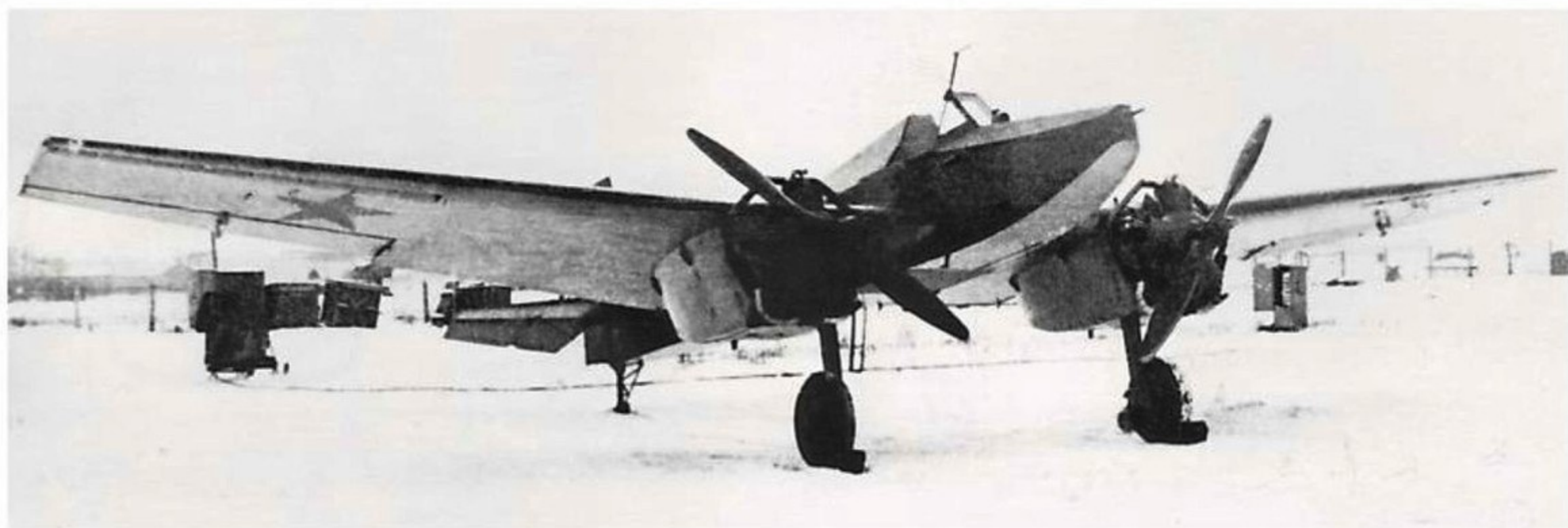
▼ Le Yak-6 n/s 0247 testé au NII VVS en 1942 avec cinq bombes de 100 kg sous le ventre et avec une mitrailleuse dorsale ChKAS de 7,62 mm, dont un millier d'exemplaires sont construits pour le bombardement léger nocturne des positions allemandes. (Marmain)
