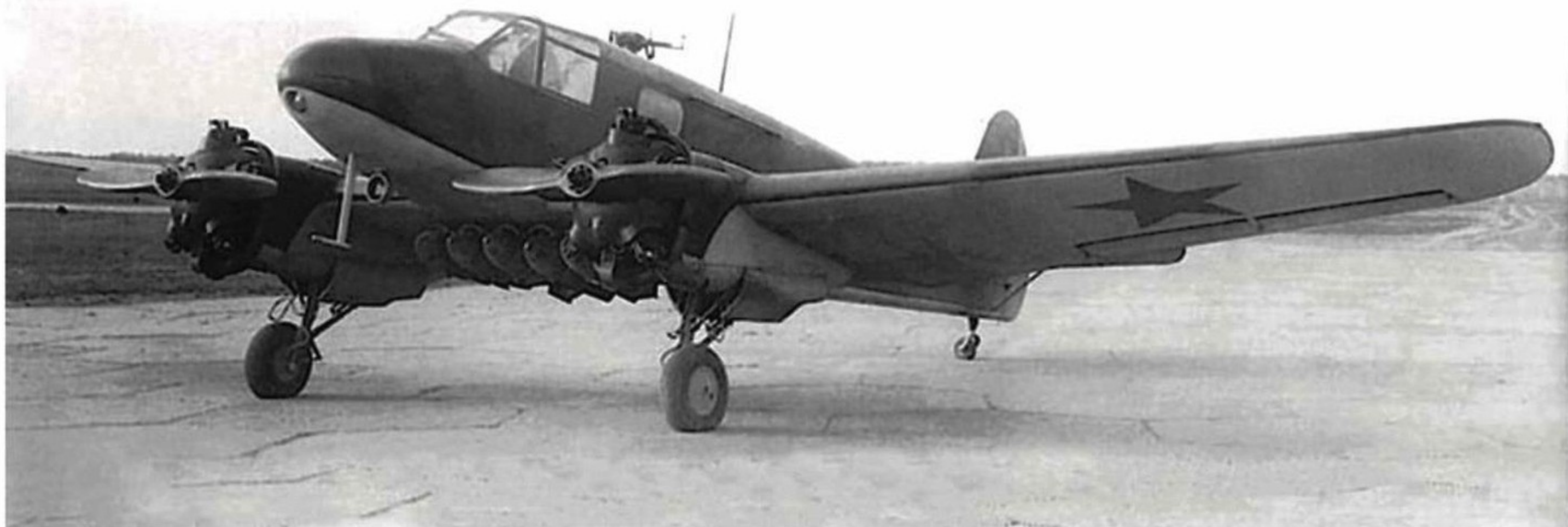
▼ Le Yak-6 n/s 0247 testé au NII VVS en 1942 avec cinq bombes de 100 kg sous le ventre et avec une mitrailleuse dorsale ChKAS de 7,62 mm, dont un millier d'exemplaires sont construits pour le bombardement léger nocturne des positions allemandes. (Marmain)
