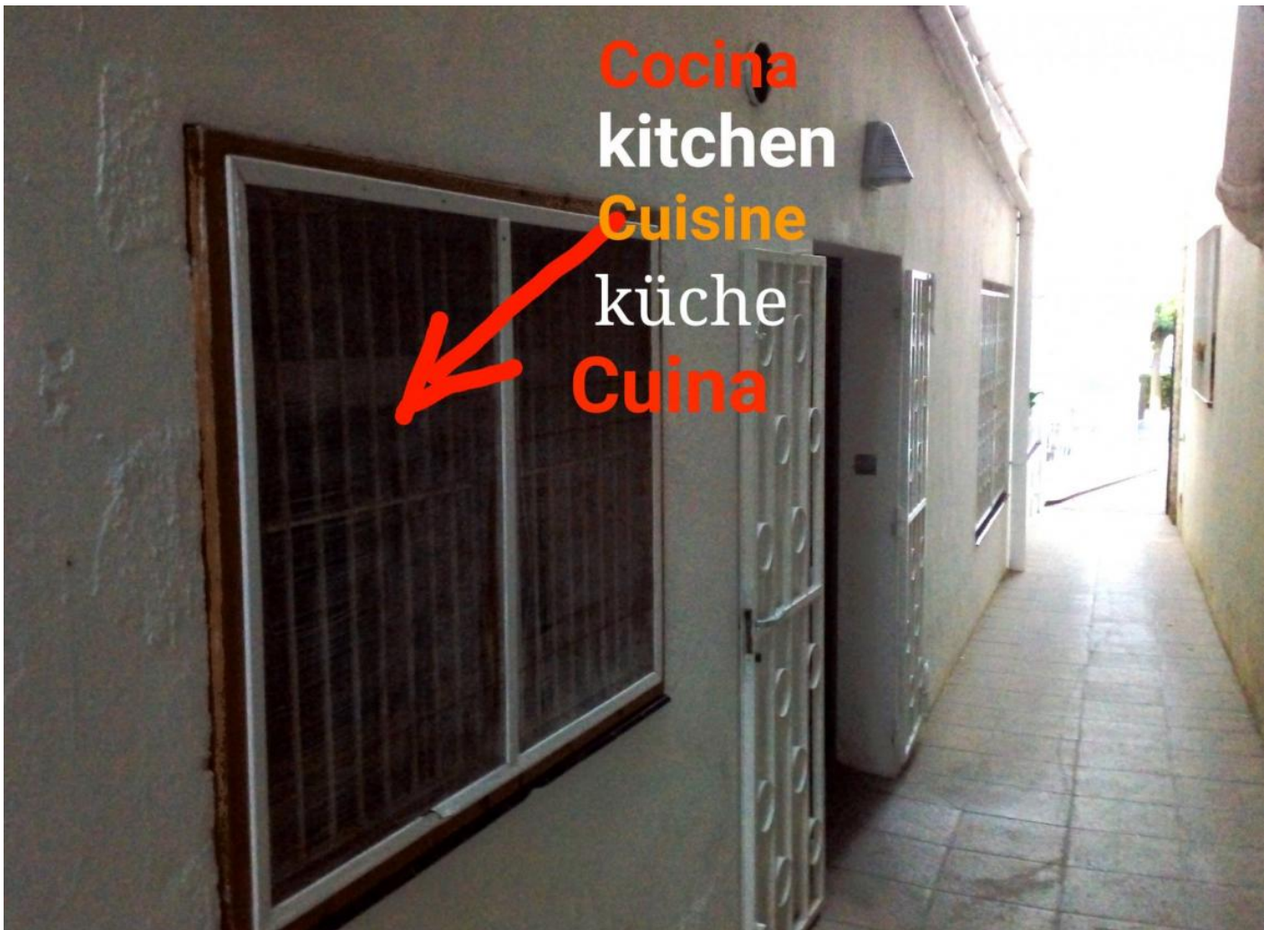
Foto ventana de la Cocina del Restaurante Santa Clara Estartit.
