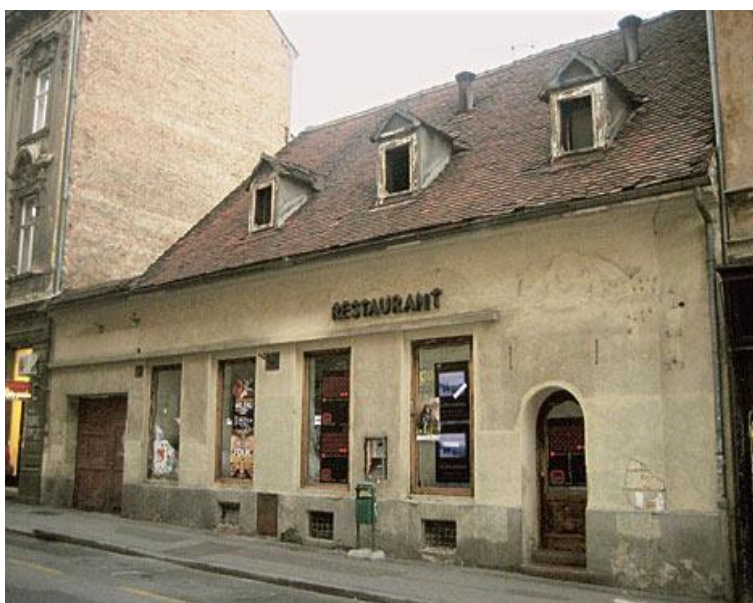
Kuće s restoranom Drina više nema, srušena je zbog dotrajalosti
