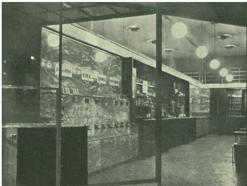
Automatski buffet u prizemlju zgrade Ilice17, snimljen početkom tridesetih
