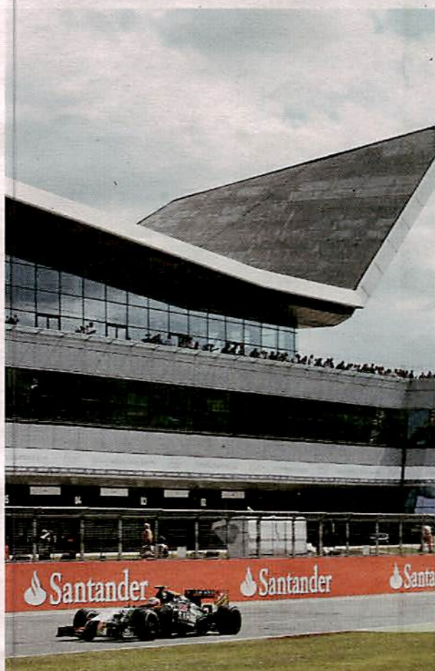
Silverstone 2014: Wing-Dach noch vor dem Sturm, der es abrisst
