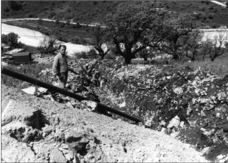
Στο έργο ύδρευσης Σφηνωτού
