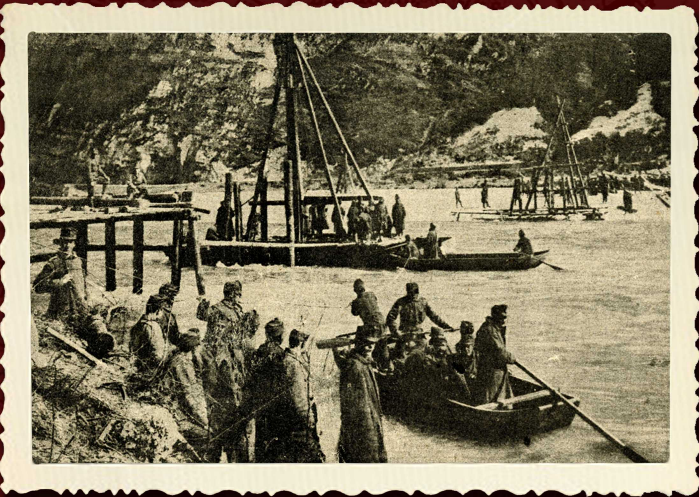
Izgradnja mosta preko Piave (Ilustrovani list, br. 18/8. lipanj 1918., str. 281)
