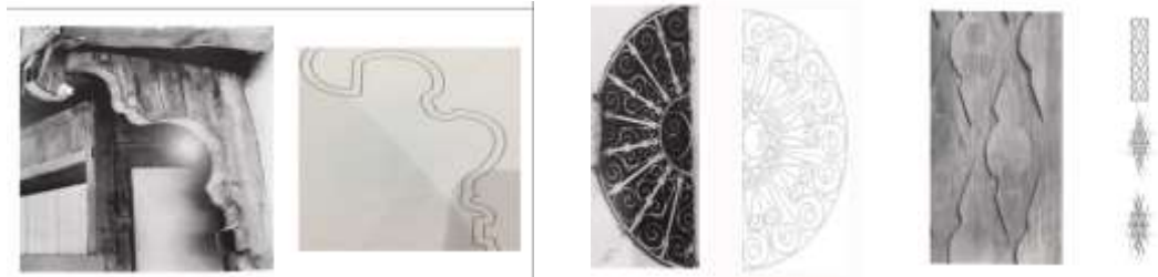
(225) حشوة روشان عنصر جمالي ووظيفي في واجهات مساكن المدينة رئيسي لأحد مباني حوش أبي شوشة (226) الجزء العلوي من الفراغات لمدخل (227) كابولي من الخشب المشغول في محلة التاجوري [كعكي]. معالم المدينة بين العمارة والتاريخ
