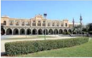
( 148 ) مبنى محطة سكة حديد الحجاز يبدو في الصورة كاملاً
