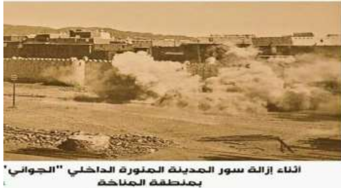
( 84 ) أثناء إزالة سور المدينة المنورة الداخلي "الجواني" بمنطقة المناخة
