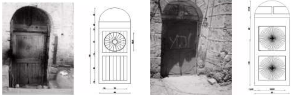
(193) باب أحد بيوت المدينة (عرض 90سم وطول 195سم) (194) باب منزل في حارة الأغوات عرض 90سم وطول 180سم [التراث المعماري ص 8 نقلاً عن كعكي . معالم المدينة] [التراث المعماري . ص 7 نقلاً عن النسيج العمراني للمدينة المنورة]
