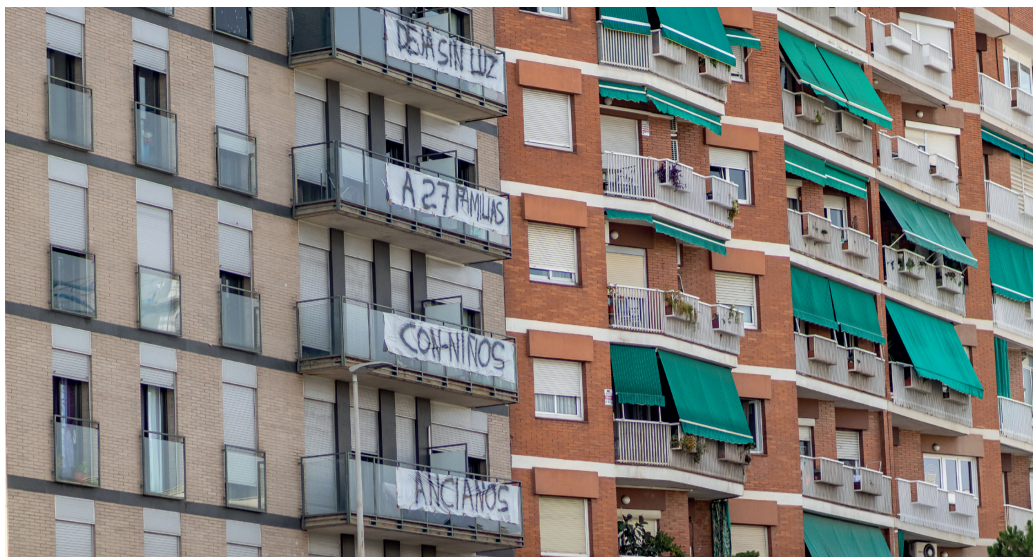
Imatge de l'edifici, situat al carrer de Puig i Cadafalch (Gran Via), sense llum des del 12 de juliol / AINA TORRES
